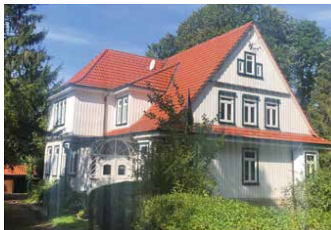
Harzer Herrenhaus in Bad Grund, Baujahr 1922
