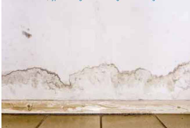
Nicht behandelte, typische Folgen von aufsteigender Feuchtigkeit
