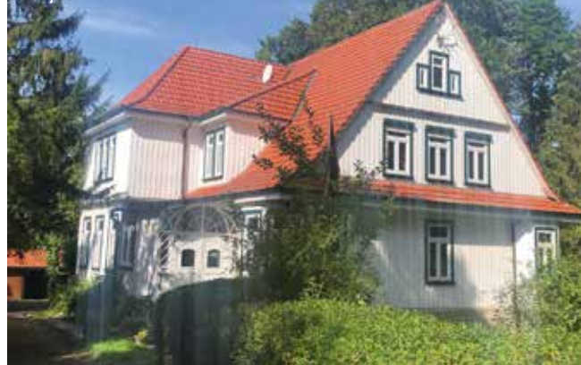
Von Freimuth saniertes Harzer Herrenhaus in Bad Grund, Baujahr 1922
