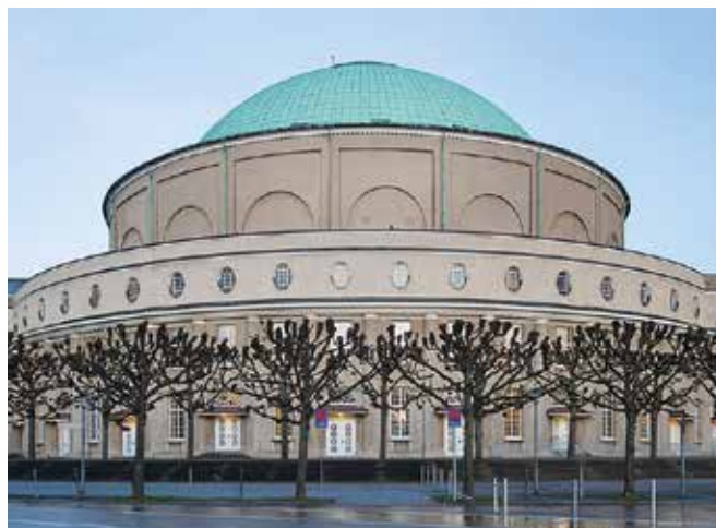
Auch das Hannover Congress Centrum (HCC) wurde durch das innovative System von der Firma Freimuth zuverlässig und dauerhaft entfeuchtet.
