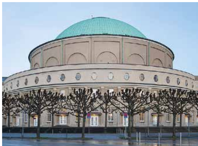
Auch das Hannover Congress Centrum (HCC) wurde durch das innovative System von der Firma Freimuth zuverlässig und dauerhaft entfeuchtet.
