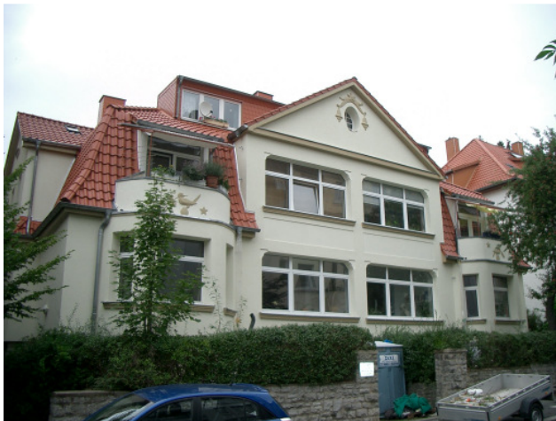
Fassaden Sanierung, Am Weißen Steine in Göttingen, in Zusammenarbeit mit H+G Hausverwaltung
